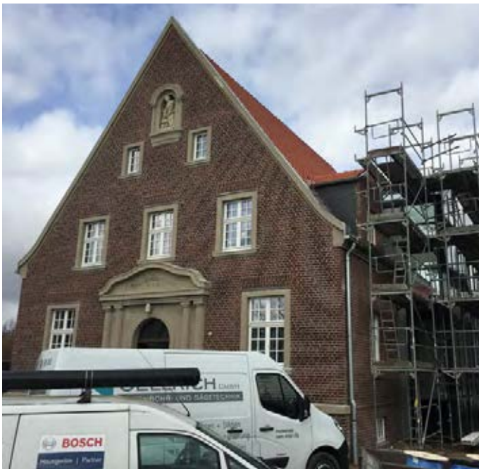
Das Schwesternhaus kurz vor der Fertigstellung nach dem Umbau im Februar 2017.
