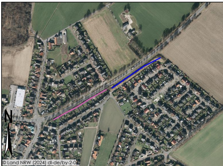
Abbildung 18: Lärmschutzwand (westlich) und Lärmschutzwand südöstlich der L572 auf Höhe der Wohnsiedlungen Walbree und Eschke
