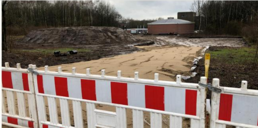
Die Baustelle für den neuen Trinkwasserspeicher in Hundewick von der L572 aus gesehen. Im Hintergrund das Wasserwerk mit dem bereits bestehenden Trinkwasserspeicher. © Stefan Großhues
