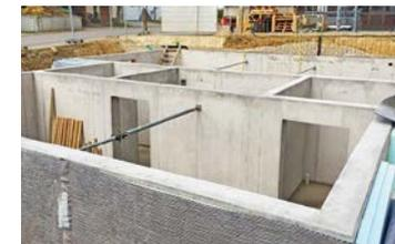
**5** Bei Neubauten wird durch den Einsatz von wasserundurchlässigem Beton (Weiße Wanne) der Kellerbereich u. a. gegen drückendes Grundwasser geschützt.
