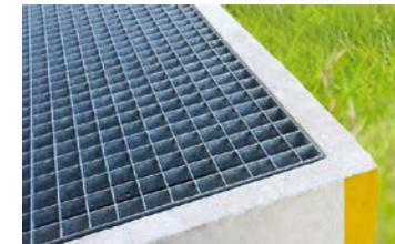
**2** Durch eine **Erhöhung** der Lichtschachtoberkanten kann Wassereintritt verhindert werden. Diese Maßnahme ist auch noch nachträglich umsetzbar.
