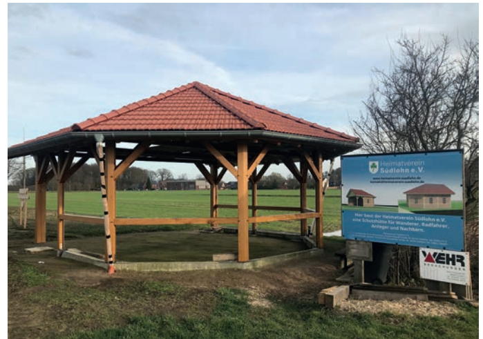
Februar 2021: Stand der Baumaßnahme
