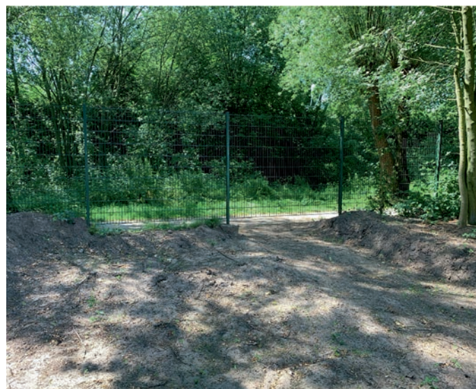
Hier entsteht ein Eingang vom Uferweg, um die Anlage noch offener zu gestalten
