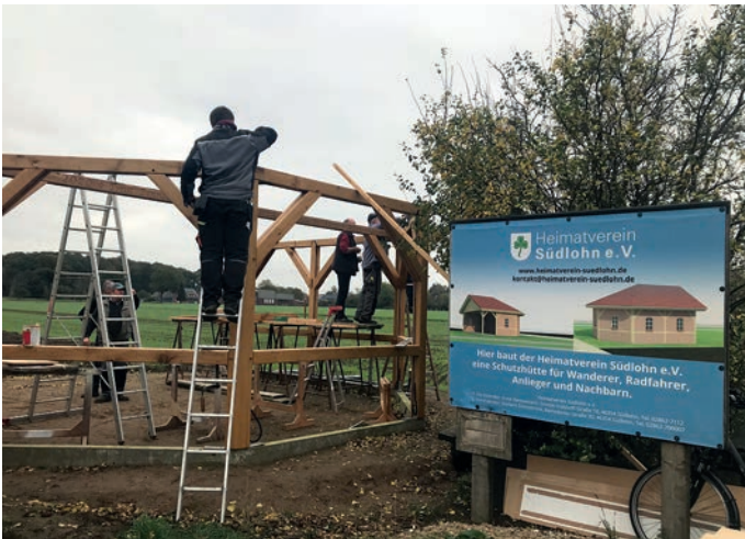
Oktober 2020: Aufbau des Eiche-Ständerwerkes
