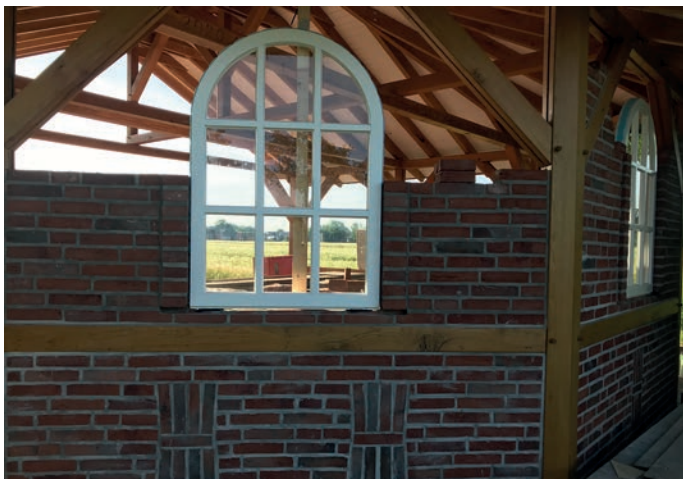
Juni 2021: Die Klinkerarbeiten sind fortgeschritten, die ersten Fenster eingebaut.
