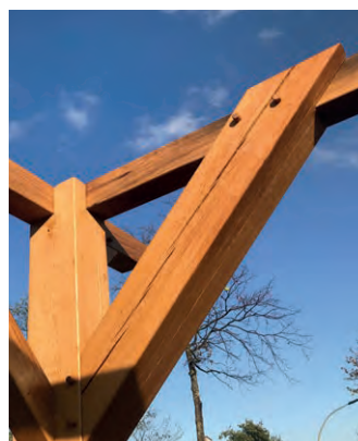
Qualität im Detail: Zimmermannsmäßige Holzverbindung mit handgefertigten Holznägeln aus Eiche.
