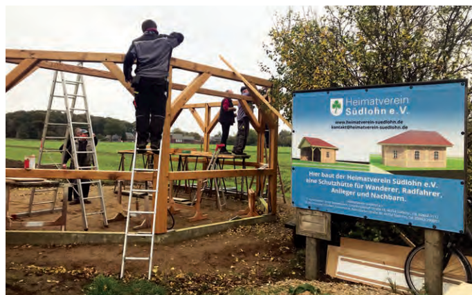
Fachhandwerker des Heimatvereins errichten das Eiche-Ständerwerk
