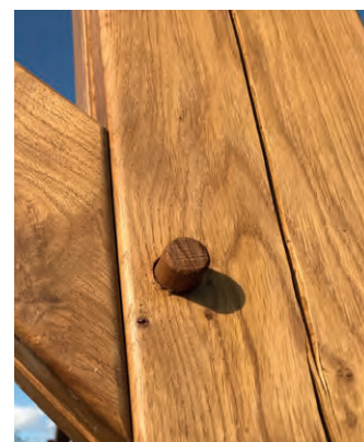
Qualität im Detail: Zimmermannsmäßige Holzverbindung mit handgefertigten Holznägeln aus Eiche.
